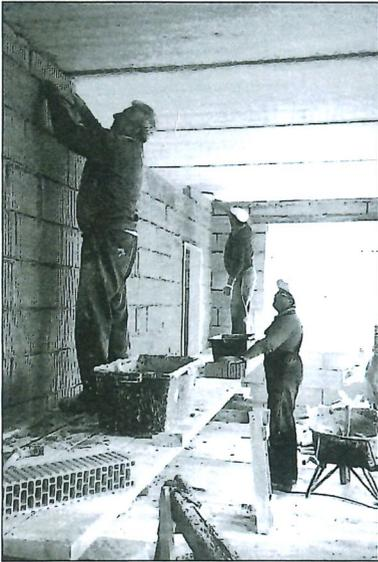
*Die Zwischenwände werden in Eigenregie aufgestellt - 12. 6. 2001*
