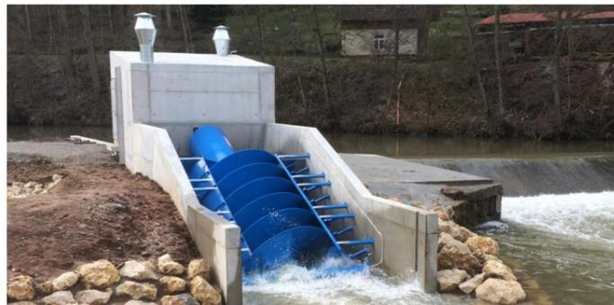
Wie für kleinere, revitalisierte Standorte nicht untypisch kommt eine sogenannte Wasserkraftschnecke (Fa. Vandezande) zum Einsatz. Wasserkraftschnecken zeichnen sich durch einen sehr effizienten Betrieb bei geringen Fallhöhen aus und sind so konstruiert, dass sie einen Fischabstieg ermöglichen.
