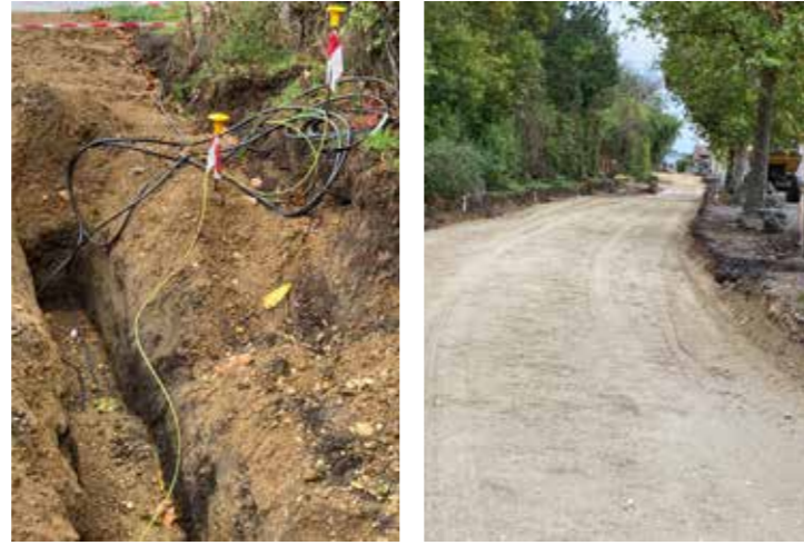
Stand der Bauarbeiten 27.09.2024 Zuleitung der PV-Anlage zu den Windrädern, Querung L2001 Batthyanystraße
